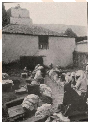
Foto: Lavadero de San Francisco, junto al canal saliente del chaboco del molino de Chano.
