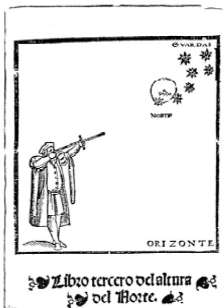
4. Empleo de la ballestilla para la obtención de la latitud por la observación de la altura de la estrella Polar sobre el horizonte. De Pedro de Medina, *Regimiento de navegación*, Sevilla, 1563.
